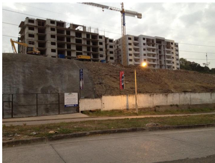
Foto 14 Estabilización de un talud donde se habían caído grandes bloques de roca.
