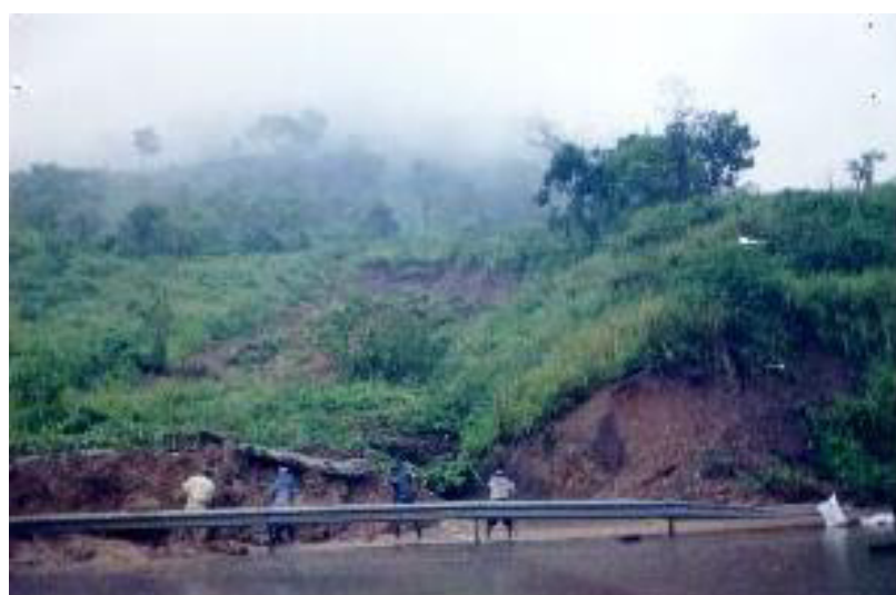
Foto 7 Deslizamiento del cerro Azul en 1998. Afectación a la vía Perimetral [31]
