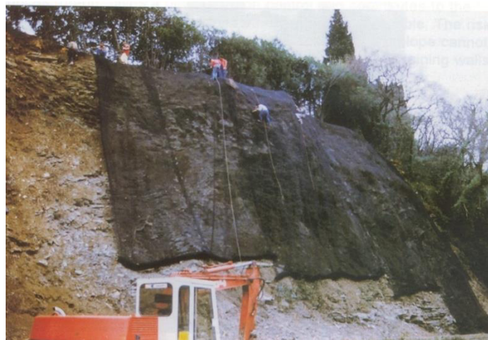
Foto 16 Geomanto para controlar la caída de fragmentos de roca meteorizada.
