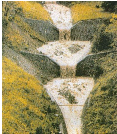
Foto 17 Canal con sistema de retención del agua sedimentos y reducción de la energía.
