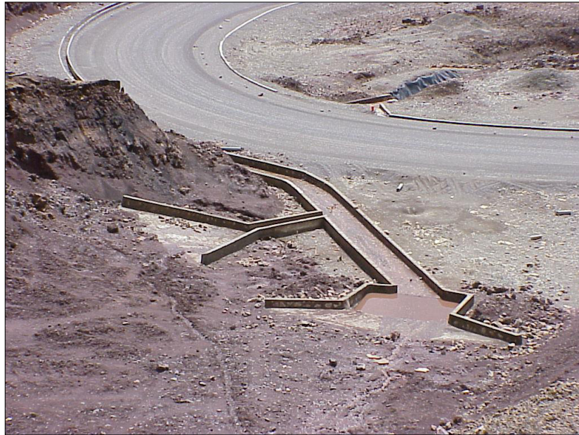
Foto 13 Control de la erosión de materiales finos sobre una calzada. Fuente: propiedad del autor de esta tesis
