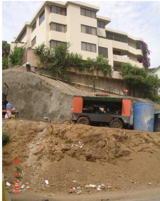
Foto 15 Corte de un talud de 80° y estabilización mediante bulones anclados, malla electro soldada, drenes filtro y una capa de hormigón proyectado.
