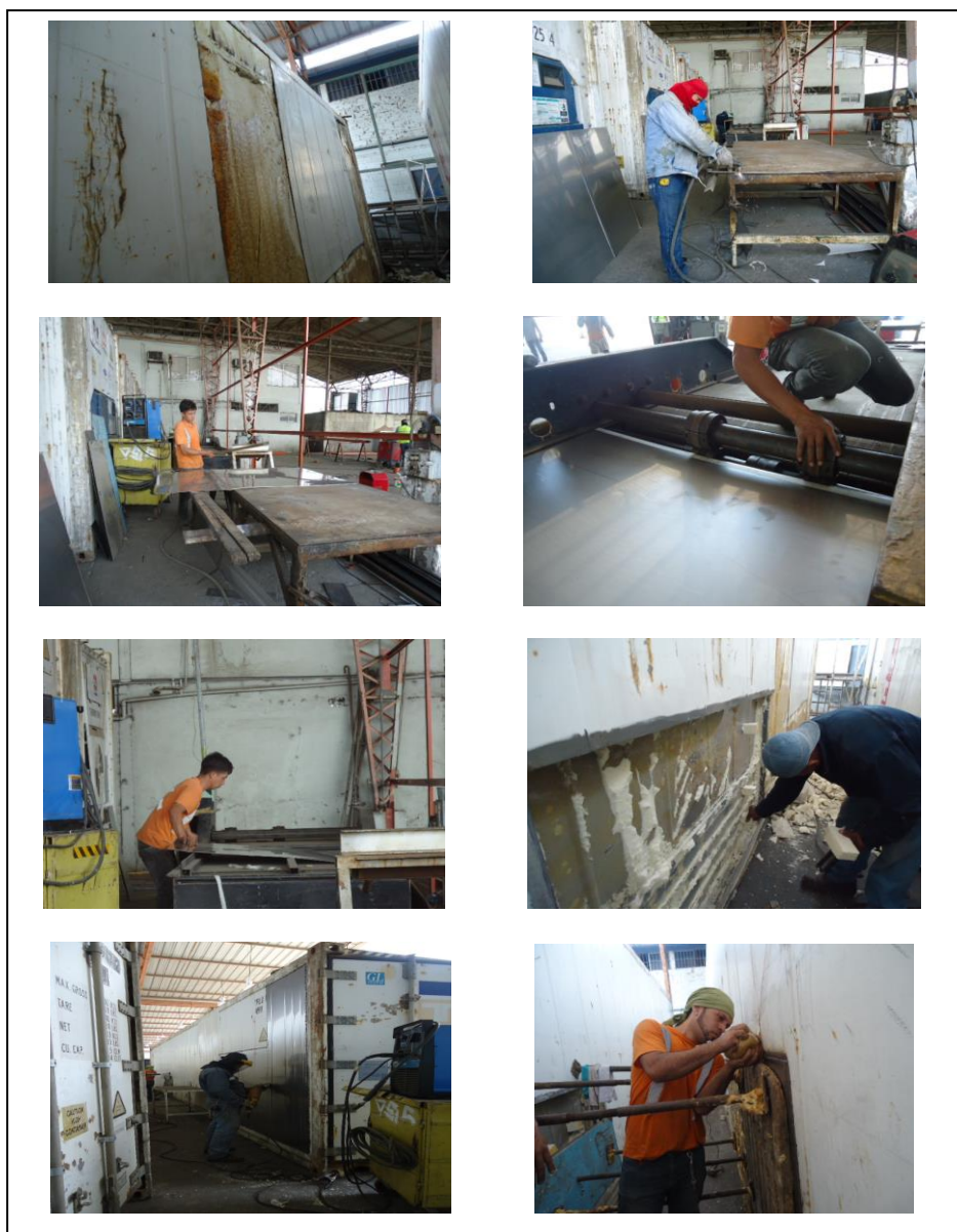
Figura 2.6. Reparación de estructura externa del contenedor
