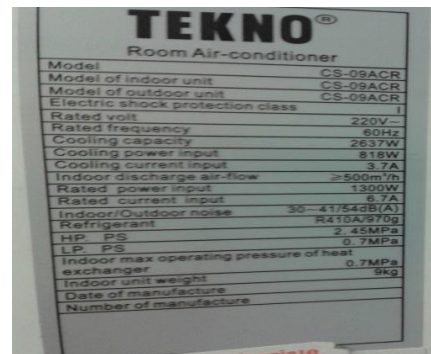
Figura 1. Datos de placa de Acondicionador de Aire
