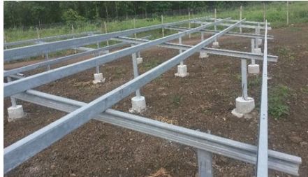
Figura 1. Estructuras de soporte
