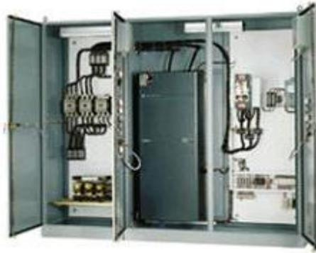
**FIGURA 2.13 VARIABLE FREQUENCY DRIVE PUMP
