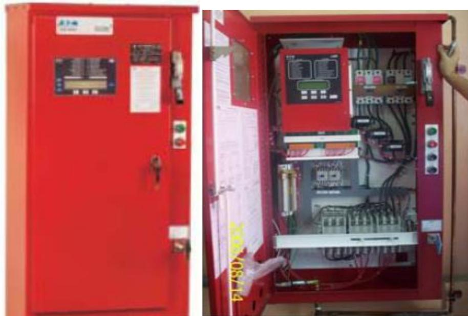
**FIGURA 3.7 TABLERO DE CONTROL DE MOTOR ELÉCTRICO**
