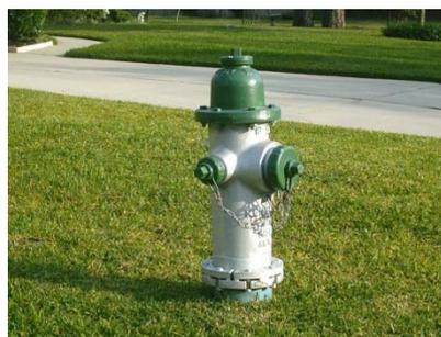
**FIGURA 2.11 HIDRANTE EXTERIOR**
