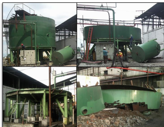
FIGURA 4.12. Desmontaje de antiguo clarificador de agua con ceniza.
