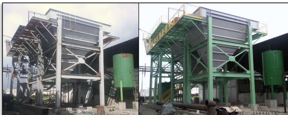
FIGURA 4.29. NUEVO SISTEMA DE CLARIFICACIÓN ANTES Y DESPUÉS DE APLICADA SU CAPA FINAL DE PINTURA.
