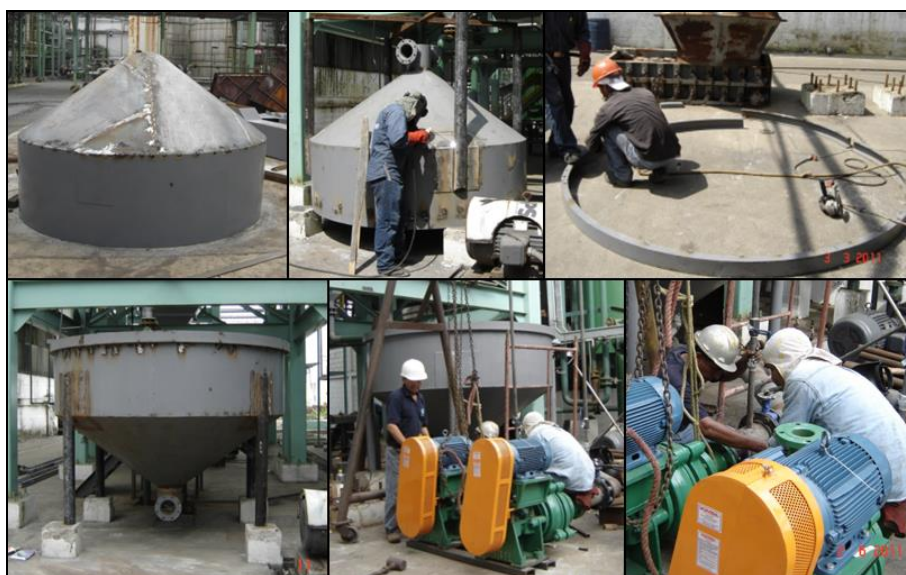
FIGURA 4.41. CONSTRUCCIÓN DE TANQUE DE LODOS E INSTALACIÓN DE SUS BOMBAS.
