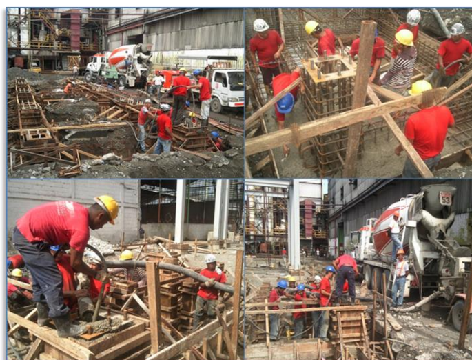
FIGURA 4.16. TRABAJOS DE VACIADO DE HORMIGÓN.
