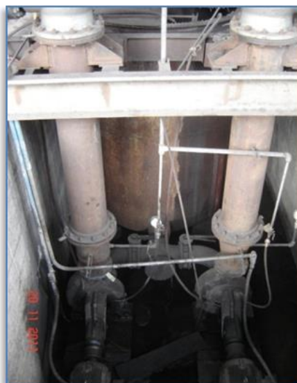
FIGURA 4.2. TANQUE RECEPTOR Y BOMBAS
