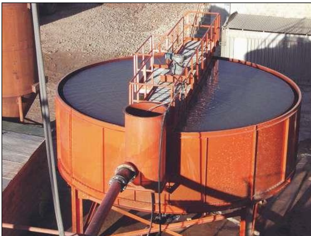
FIGURA 2.4. DECANTADOR DE CENIZA TIPO BANDEJA Y RASTRAS
