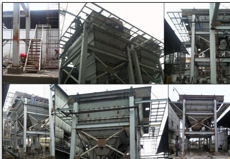
FIGURA 4.24. CONSTRUCCIÓN E INSTALACIÓN DE PLATAFORMAS DE OPERACIÓN, ESCALERAS Y PASAMANOS.
