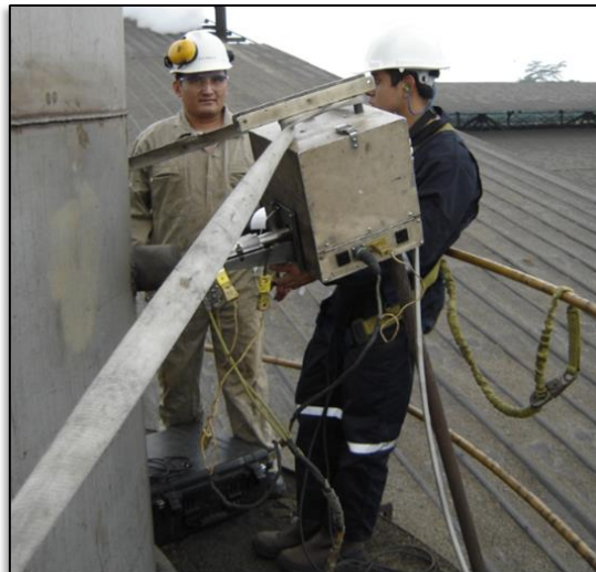
FIGURA 5.3. AUTOR DE ESTE PROYECTO DE TESIS DURANTE MONITOREO DE GASES DE COMBUSTIÓN DE LA CALDERA #8.
