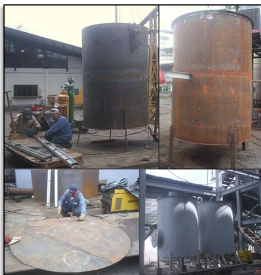
FIGURA 4.27. CONSTRUCCIÓN DE TANQUES DE FLOCULANTE.
