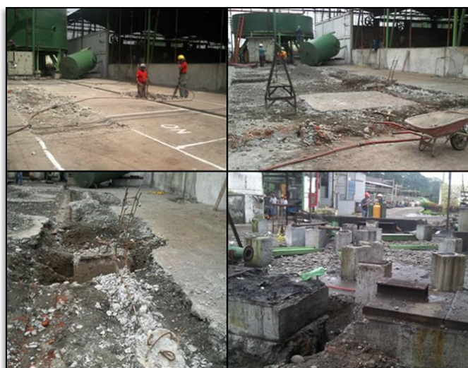
FIGURA 4.13. TRAZADO Y DEMOLICIONES PARA OBRA CIVIL
