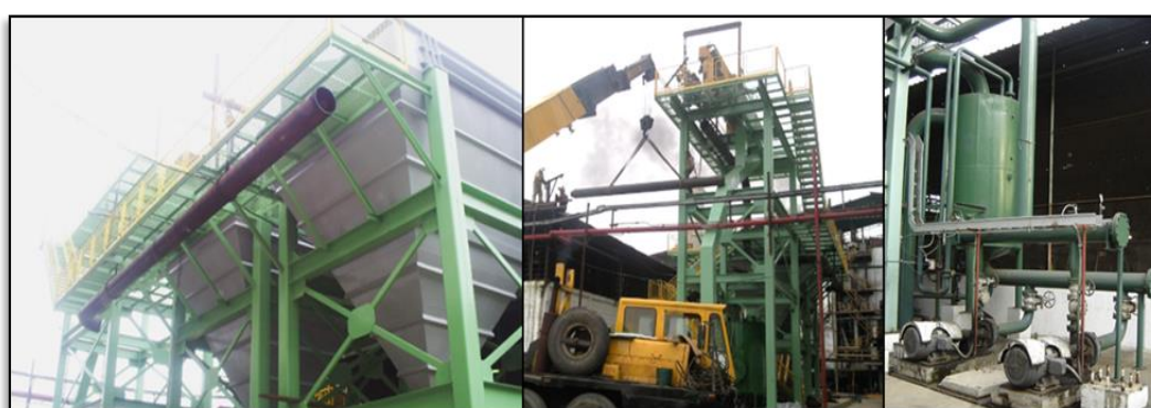
FIGURA 4.30. MONTAJE DE TUBERÍAS.
