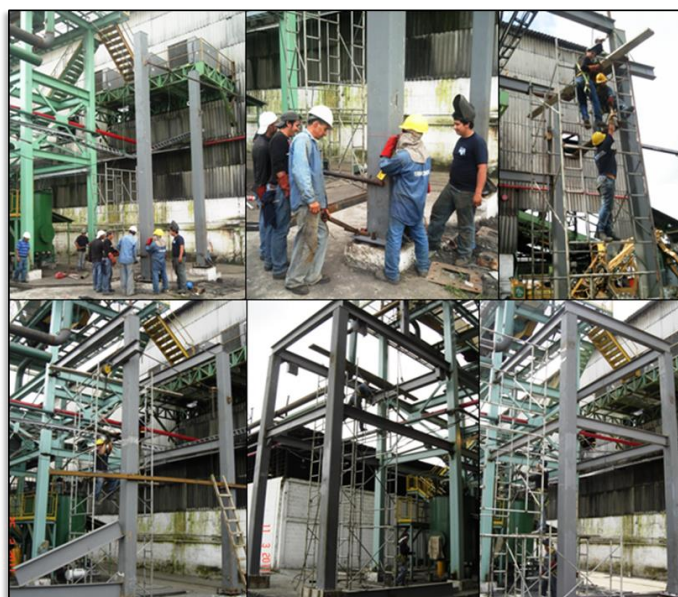
FIGURA 4.36. MONTAJE DE NUEVA ESTRUCTURA SOPORTE PARA LA PRENSA DESAGUADORA.
