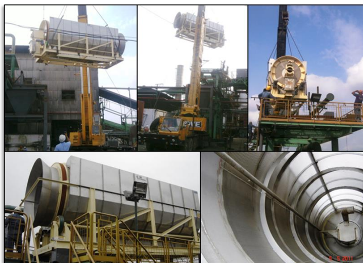
FIGURA 4.38. MONTAJE DE TAMIZ ROTATIVO.
