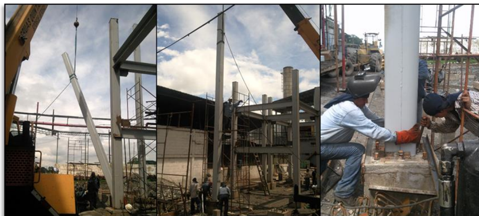
FIGURA 4.21. MONTAJE DE COLUMNAS.
