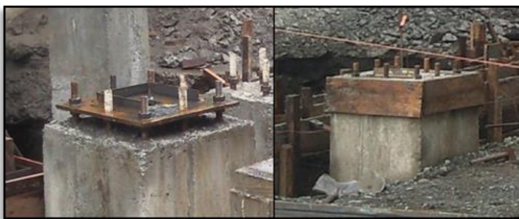
FIGURA 4.19. INSTALACIÓN DE PLACA BASE Y RELLENO CON GROUTING.
