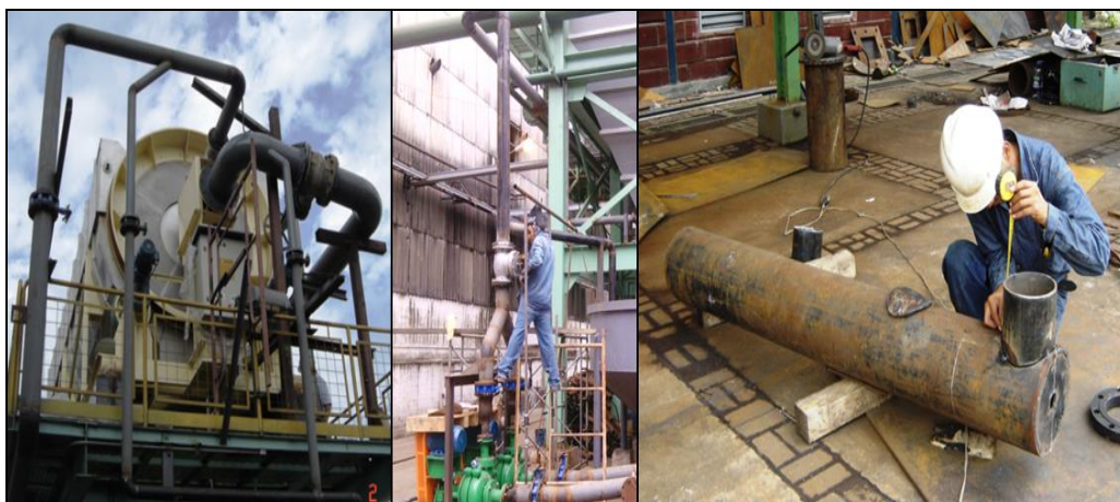
FIGURA 4.43. MONTAJE DE TUBERÍAS DE INTERCONEXIÓN – 2DA ETAPA.
