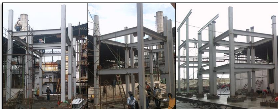
FIGURA 4.22. MONTAJE DE VIGAS DE AMARRE ENTRE COLUMNAS.
