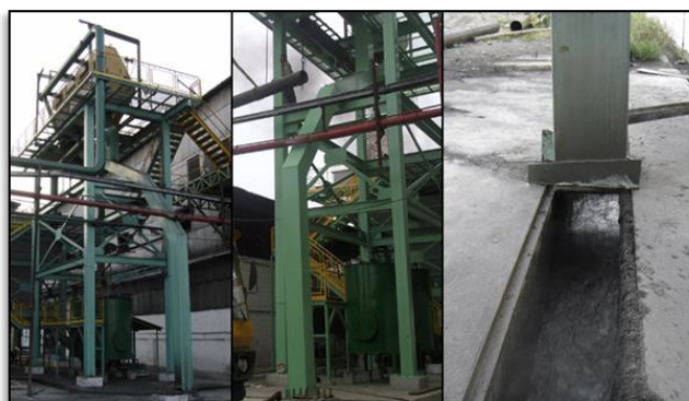
FIGURA 4.26. CANALÓN DE DESCARGA DE CENIZA DESDE EL TAMIZ ESTÁTICO.
