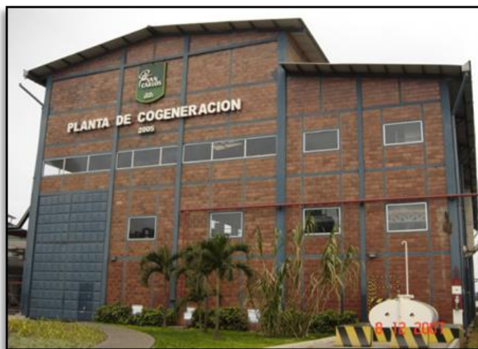
FIGURA 1.8. EDIFICIO DE COGENERACIÓN – INGENIO SAN CARLOS
