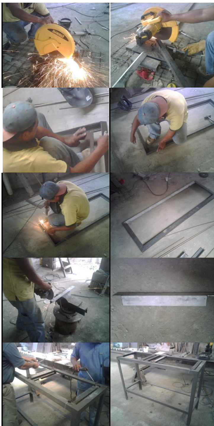
FIG. 2.10 PROCESO DE CONSTRUCCIÓN DE LA ESTRUCTURA METÁLICA
