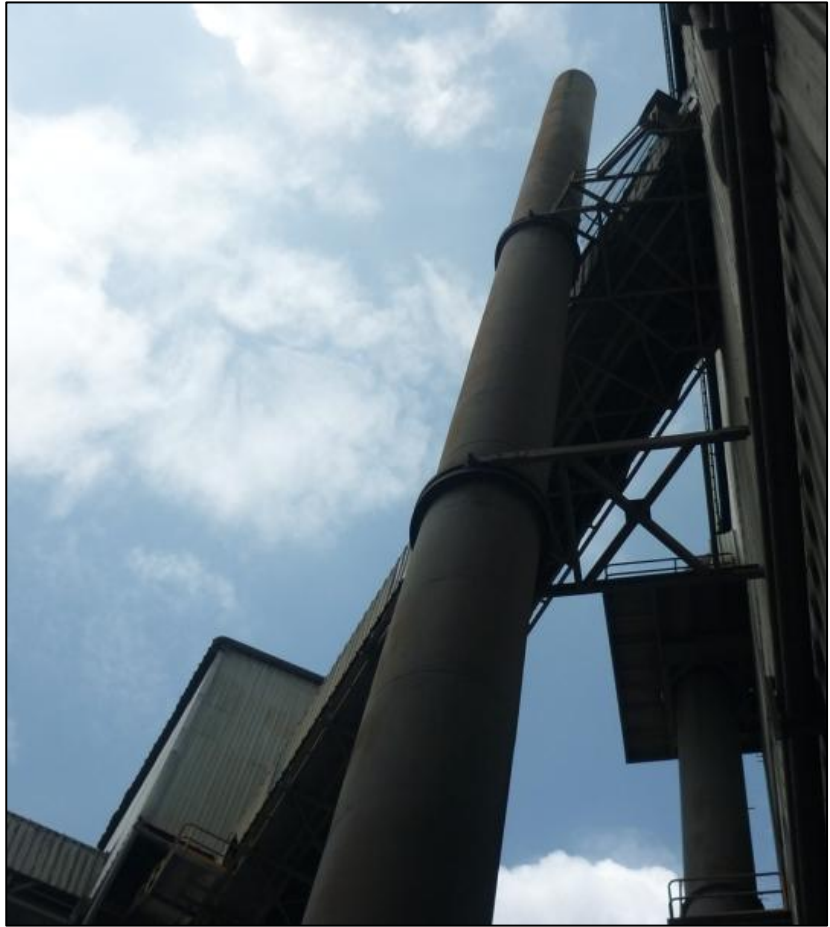
FIGURA 2.1. VISTA PANORÁMICA DE LA CHIMENEA
