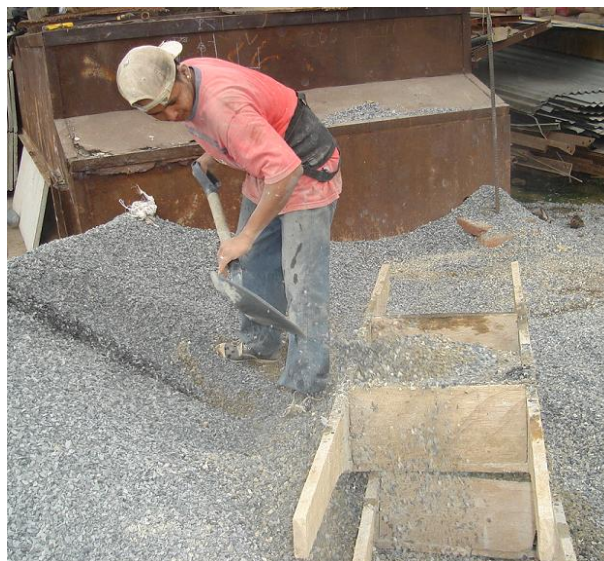
Figura 4.19. Operario paleando agregados
