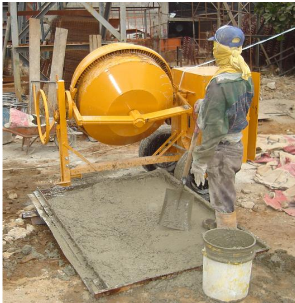
Figura 4.12. Área de descarga de mezcla
