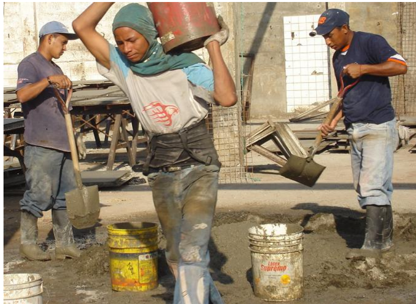
Figura 4.10. Mezclado manual
