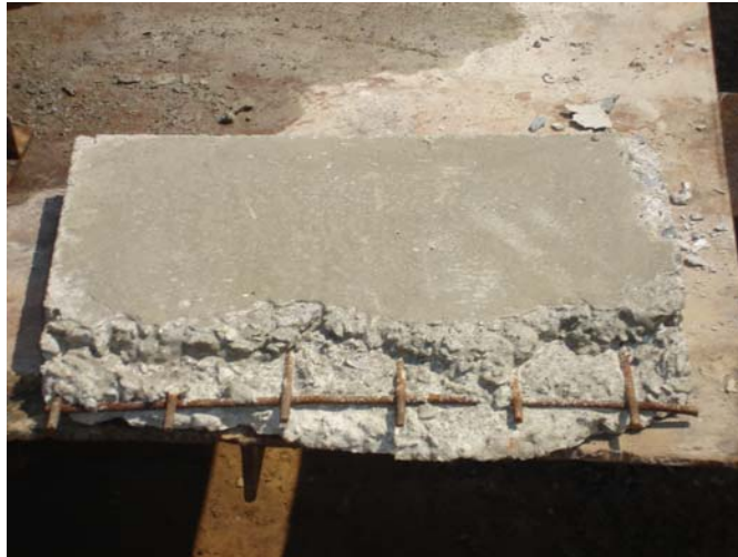
Figura 3.3. Vista interior de panel de hormigón
