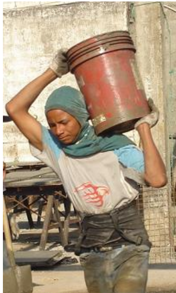
Figura 4.14. Carga de balde sugerido para mezcla
