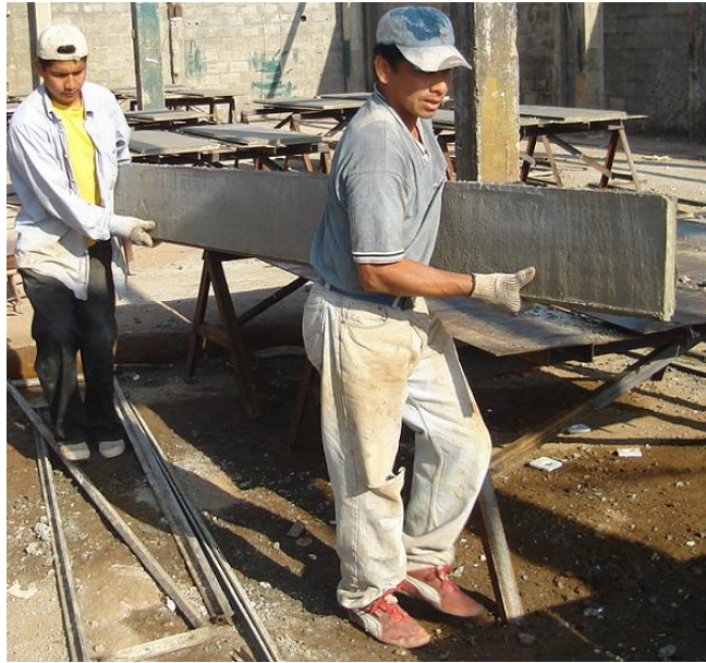
Figura 4.16. Transporte manual de paneles de hormigón
