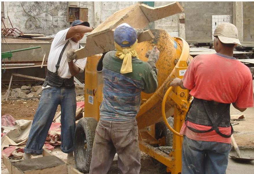
Figura 4.11. Mezclado asistido por máquina
