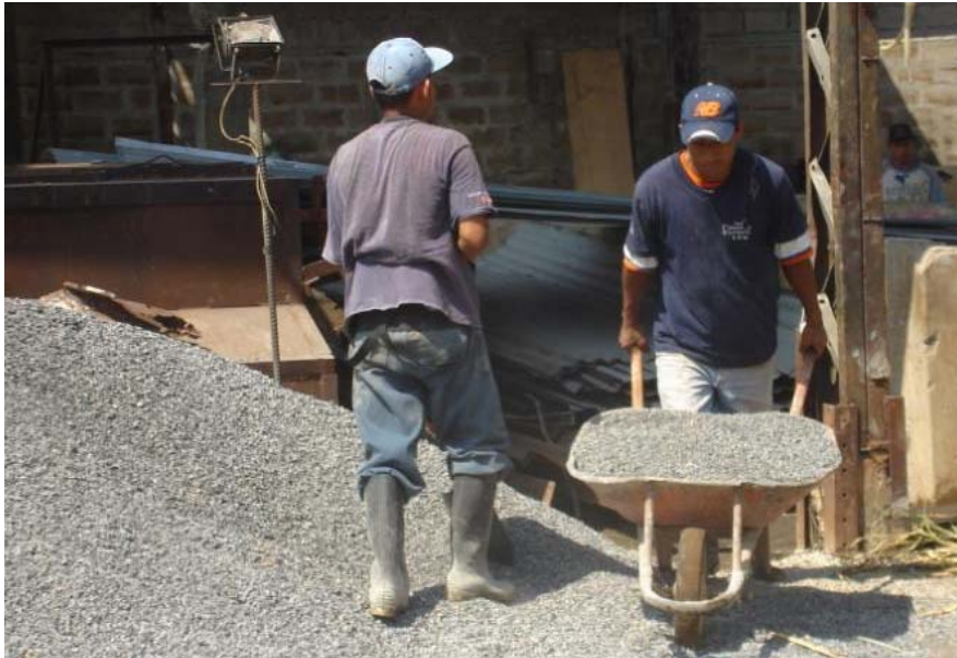
Figura 4.1. Operarios cargando agregados en carretilla
