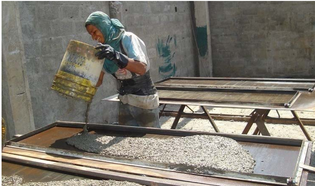
Figura 4.3. Operario provee de mezcla a molde
