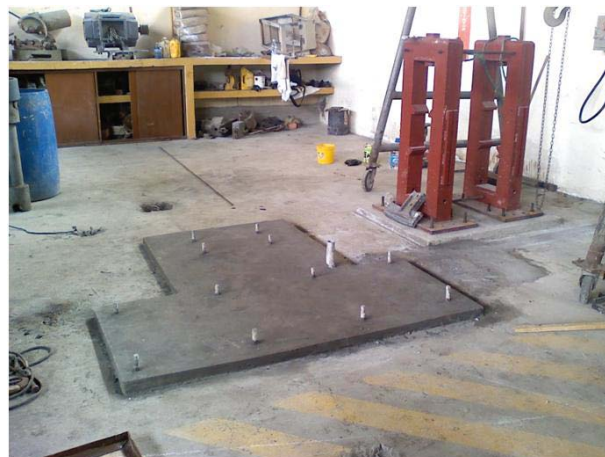
FIGURA 2.35. CIMENTACION DEL MOTO-REDUCTOR
