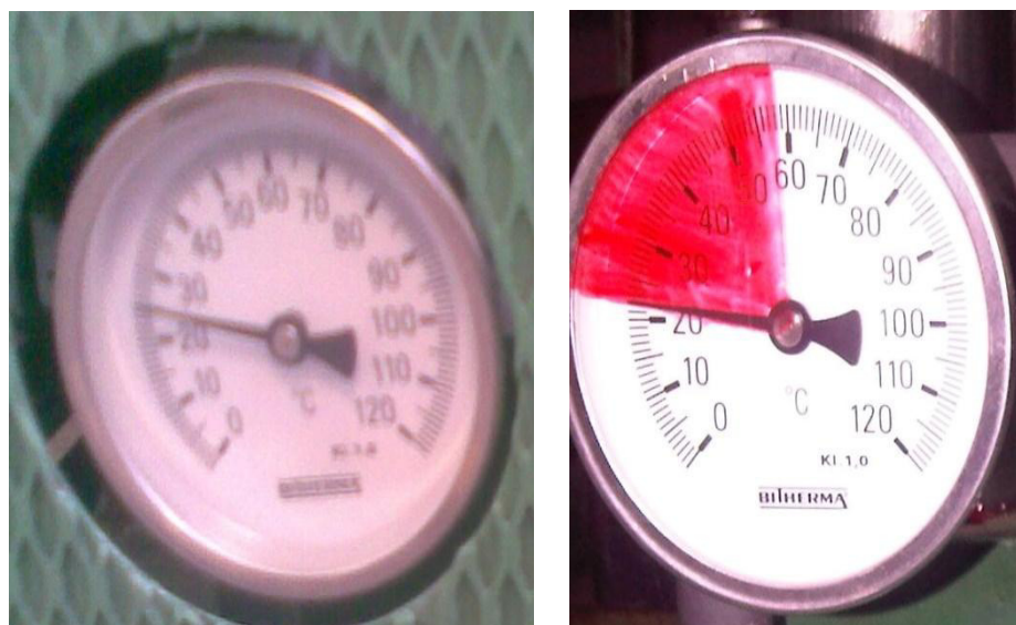
FIGURA 4.39. CONTROL VISUAL EN MANÓMETROS
