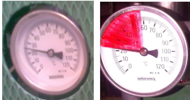
FIGURA 4.8. CONTROL VISUAL EN MANÓMETROS
