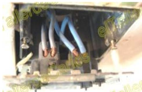
transformador sin uso junto a la pizarra de producción que en invierno puede producir corto circuito y por el material requerido para la máquina procesadora puede causar un incendio de grandes proporciones. Esto incumple con el numeral 3 del Artículo 11 del Decreto Ejecutivo 2393, en el que se establece mantener en buen estado de servicio las instalaciones, máquinas, herramientas y materiales para un trabajo.
