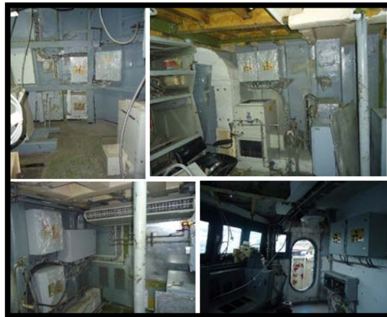
Figura #4: Adecuaciones iniciales
