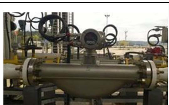
**Figura 14. Transmisor tipo Coriolis**
