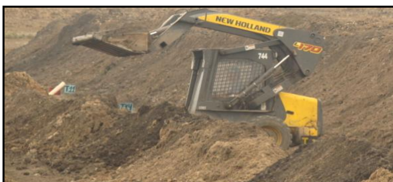
FIGURA 2.3: Volteo de Pilas
