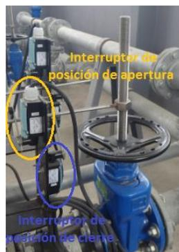
**Figura 13.** Acoplamiento de dos interruptores de posición a una válvula.
