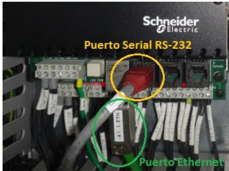
**Figura 5.** Puertos de comunicación de la RTU SCADAPack 334 E.
