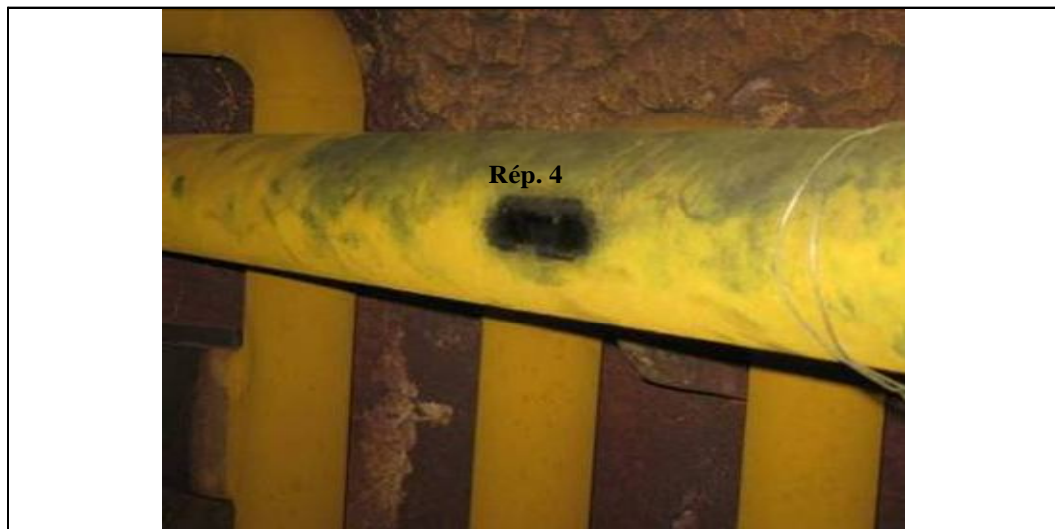
Fig. 17 Ubicación en zona convectiva-Techo. Tubo de Unión Paso 1 y 2.
