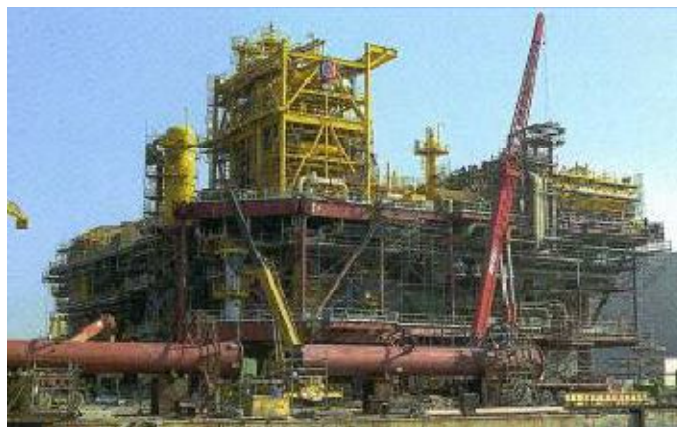
Figura 1.1 INSTALACIONES EN MONTAJE – CONTROL INICIAL
