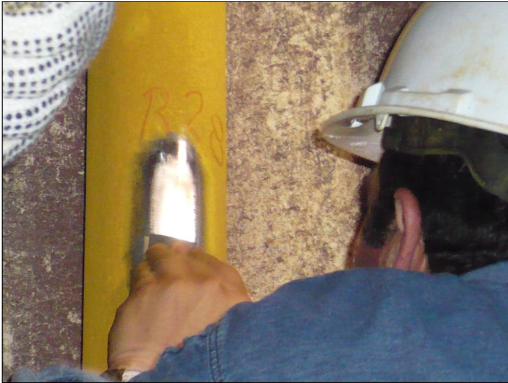
Figura 2.5 PULIDO MANUAL CON PAPELES DE GRANULOMETRÍA #400 Y 600
