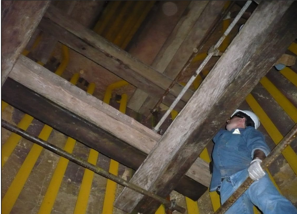
Figura 2.2 Inspección visual interior Horno Catalítico.
