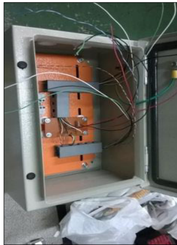
FIGURA. 2.11. CAJA CON LA PLACA DE BAQUELITA INSTALADA.
