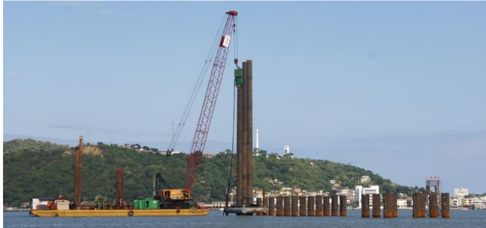
FIGURA 1.2 HINCADO DE PILOTES EN EL TRAMO CENTRAL (1)
