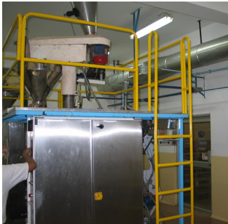
FIGURA 4.6. PLATAFORMA, ESCALERA Y BARANDA DE SEGURIDAD DE ENVASE DE BEBIDAS DE CHOCOLATE.
