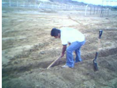
Zanja para manguera
