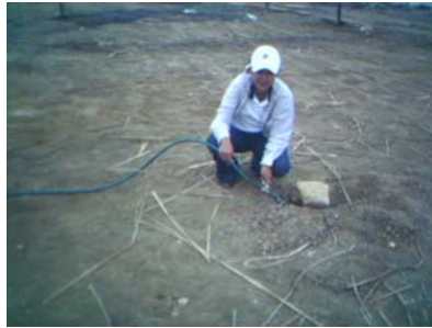
Mangueras para riego
