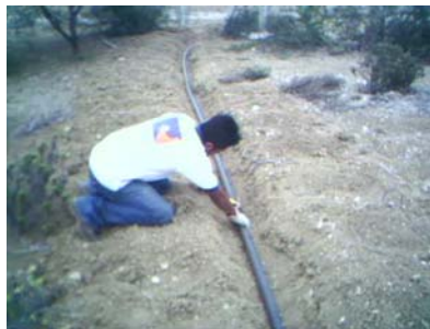
Colocación de tubería
