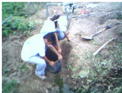
Colocación de tanque para medición de caudal
