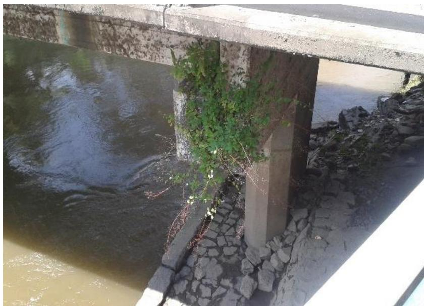
Fotografía 7. Presencia de maleza en una de sus pilas.
