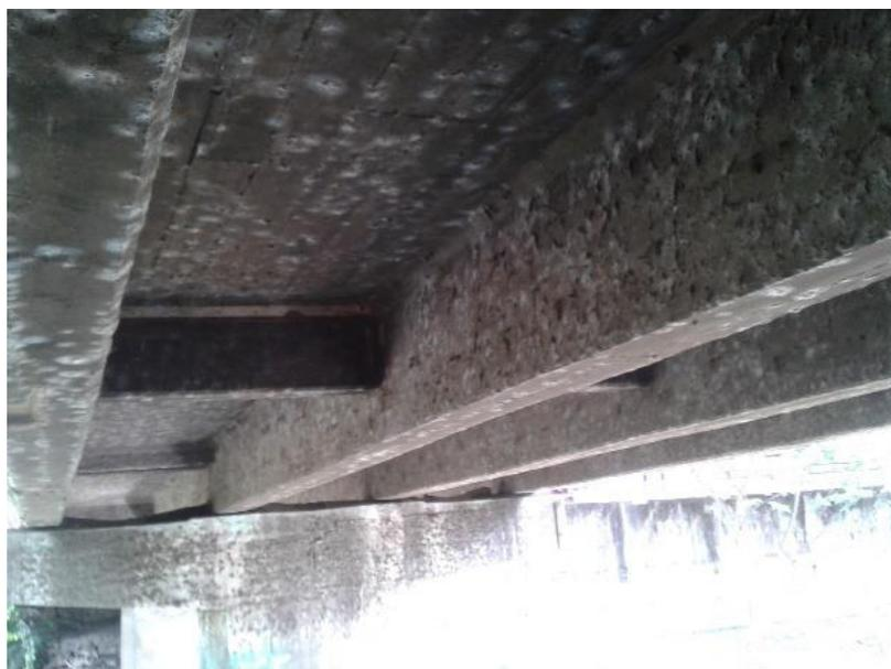
Fotografía 5. Presencia de humedad en vigas de puente "Chirijos".
