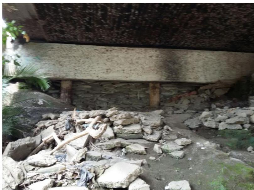
Fotografía 8. Vista de Estribo y pilotes expuestos.
