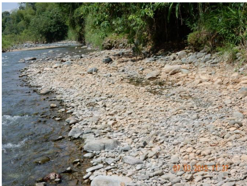
Fotografía 5.- Azolvamiento en el río
