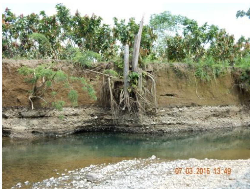
Fotografía 6.- Socavación en el cauce
