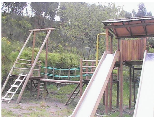
Figura 93.- Adecuaciones en la laguna de Guabizhún
