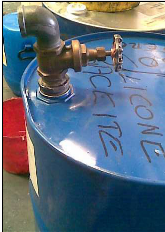
Figura 5.13 Llave 1 1/4" colocada en tanques de aditivos
