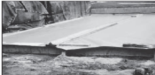
FIGURA. 2.1 LOSAS CUBIERTAS CON LAMINAS PLASTICAS
