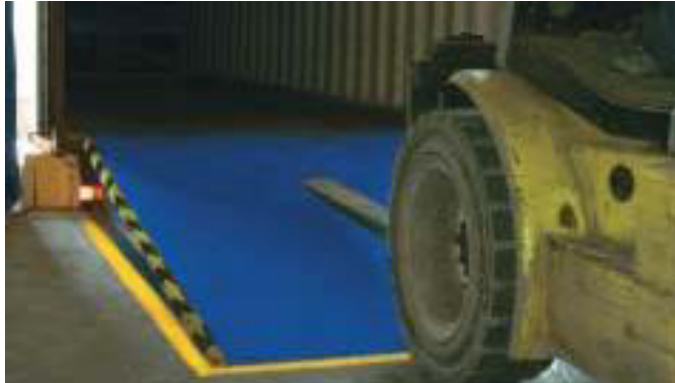
FIGURA 5.5. FOTO DE RAMPA DE ALTURA VARIABLE
