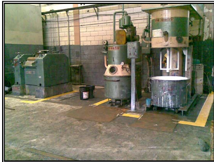
FIGURA 4.9. LINEAS ÁREA DE EQUIPOS
