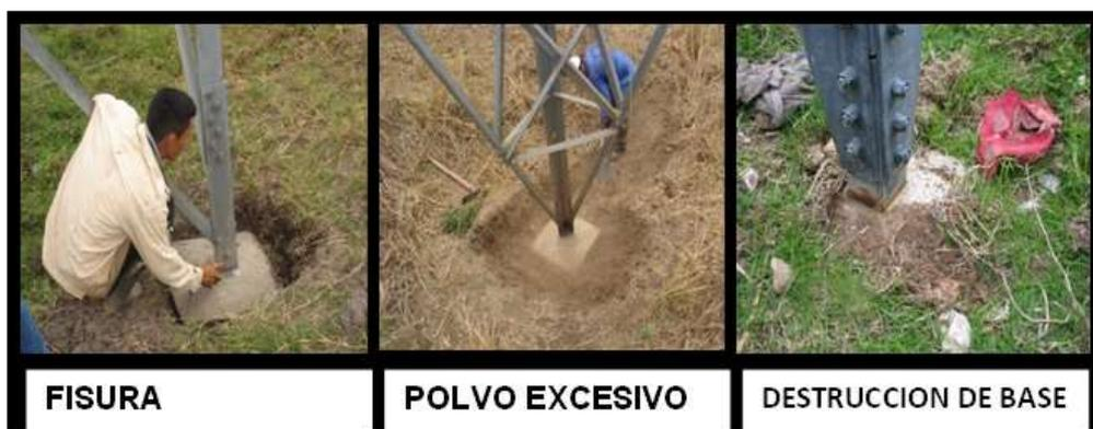
**FIGURA1.7 BASES DE HORMIGON CON CORROSIÓN**
