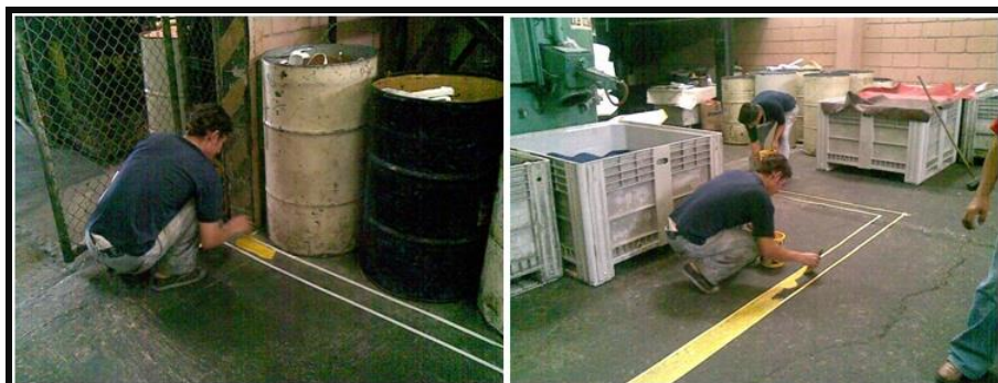
FIGURA 4.5. PINTURA DEL PISO
