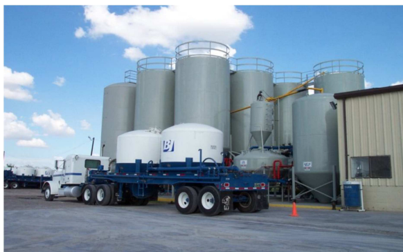
Figura 1.12 - Almacenamiento de cemento seco. Fuente: BJ-Services.
