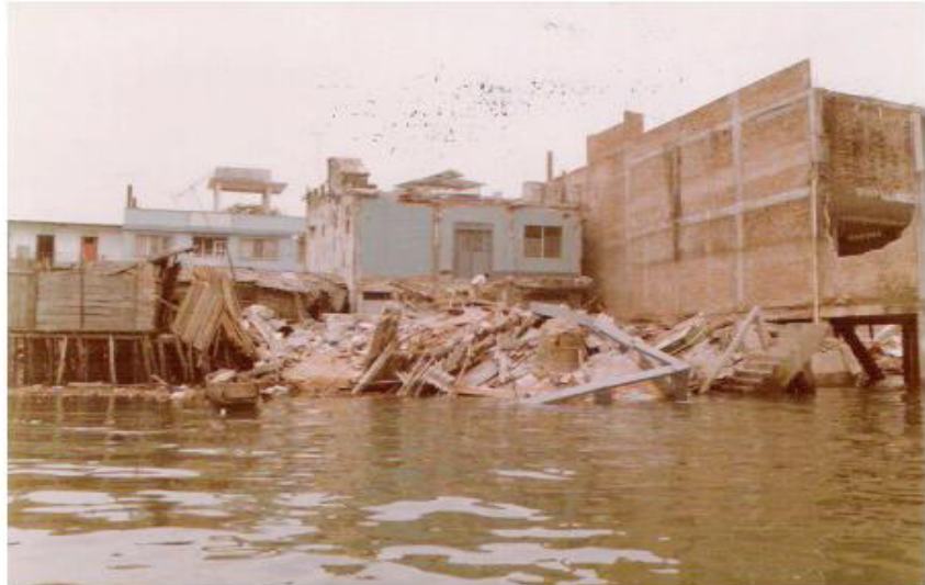
Figura 3.1: Daños ocasionados por el Tsunami en Tumaco Fuente: Fotografía tomada por G. Pararas-Carayannis
