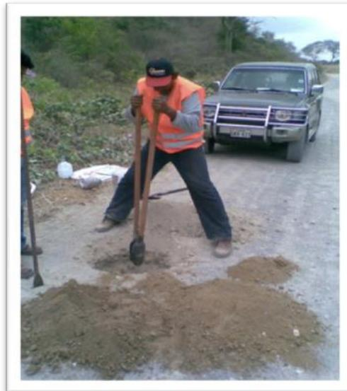
**Fotografía #20:** Excavación a base de barra y barretas de la Calicata #3 profundidad total 1.5 metros, abscisa 1+420 lado izquierdo
