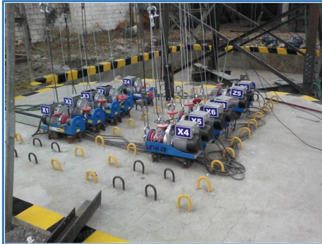
Figura 3.4. Base de hormigón para anclaje tecles
