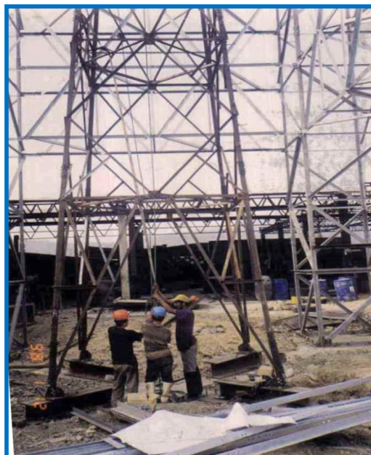
Figura 2.5. Torre instalada banco
