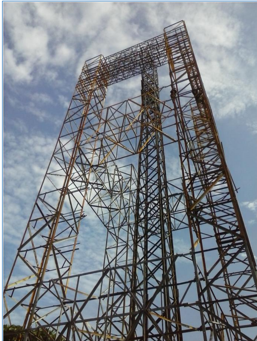
Figura 3.16. Torre y banco listo
