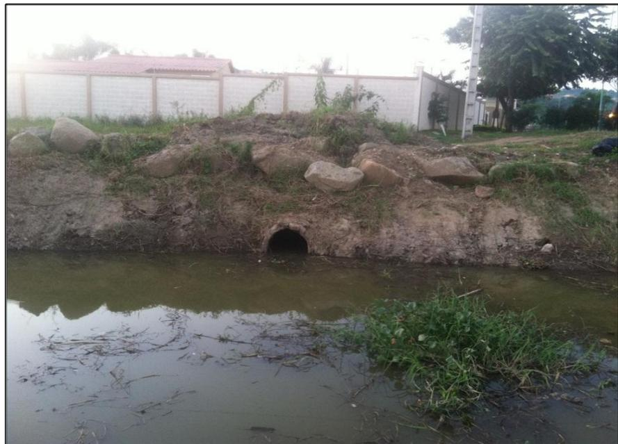
**Foto 1.4.-** Canal azolvado, nótese la presencia de un tubo de descarga lateral hacia el canal. Fuente: Autores, Junio 2015.
