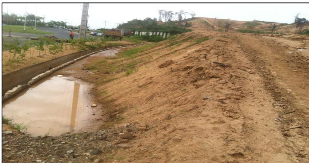
**Foto 7.12.-** Fotografía de charcos de agua empozada al pie de un talud por operaciones de excavación. Fuente: Autores, Agosto 2015.
