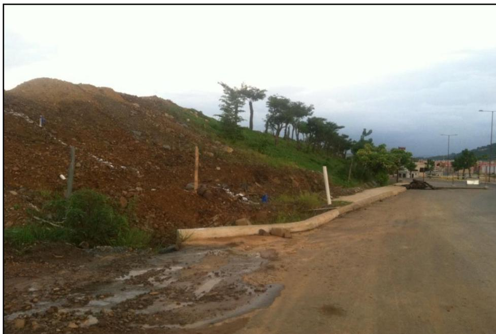
**Foto 7.2.-** Se aprecia como el material erosionado invade las cunetas, reduciendo la capacidad de desagüe de las mismas.
