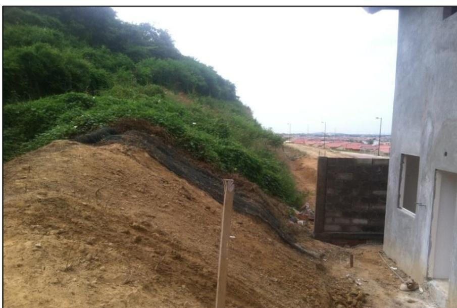
**Foto 7.8.-** Vivienda construida junto a un talud sin estabilizar.
