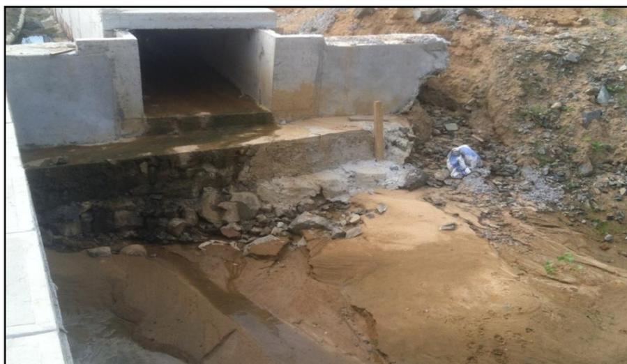
**Foto 7.7.- Material erosionado saliendo del alcantarillado pluvial. Fuente: Autores, Agosto 2015.**
