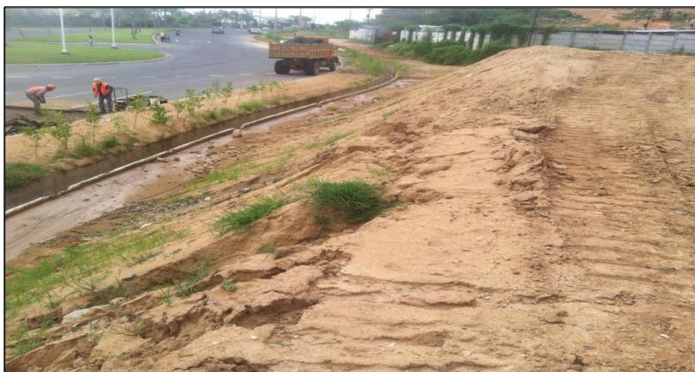
**Foto 7.11.-** Talud erosionado por las operaciones constructivas de la urbanización. Fuente: Autores, Agosto 2015.
