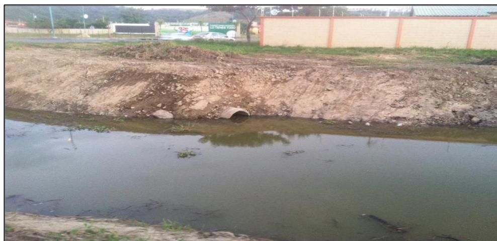
**Foto 7.13.-** Canal con agua estancada, generación de malos olores y criadero de mosquitos. Fuente: Autores, Agosto 2015.
