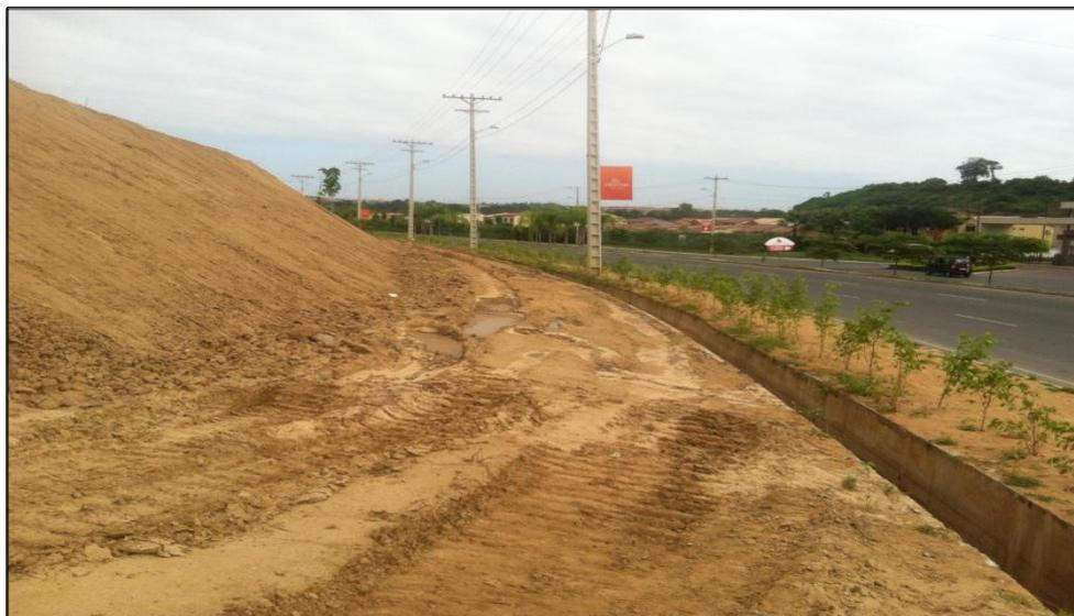
**Foto 7.9.-** Zona de excavación en donde se puede apreciar como el material erosionado esta esparcido a lado de la zanja de drenaje. Fuente: Autores, Agosto 2015.
