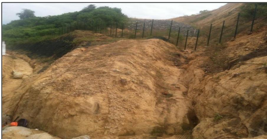
**Foto 7.6.- Talud rocoso con peligro de deslizamientos por fatal de estabilización. Fuente: Autores, Agosto 2015.**
