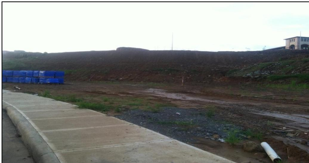
**Foto 7.3.-** Foto de una zona de excavación y taludes sin estabilizar, propensa a deslizamiento, La Joya etapa Opalo. *Fuente: Autores, Agosto 2015.*
