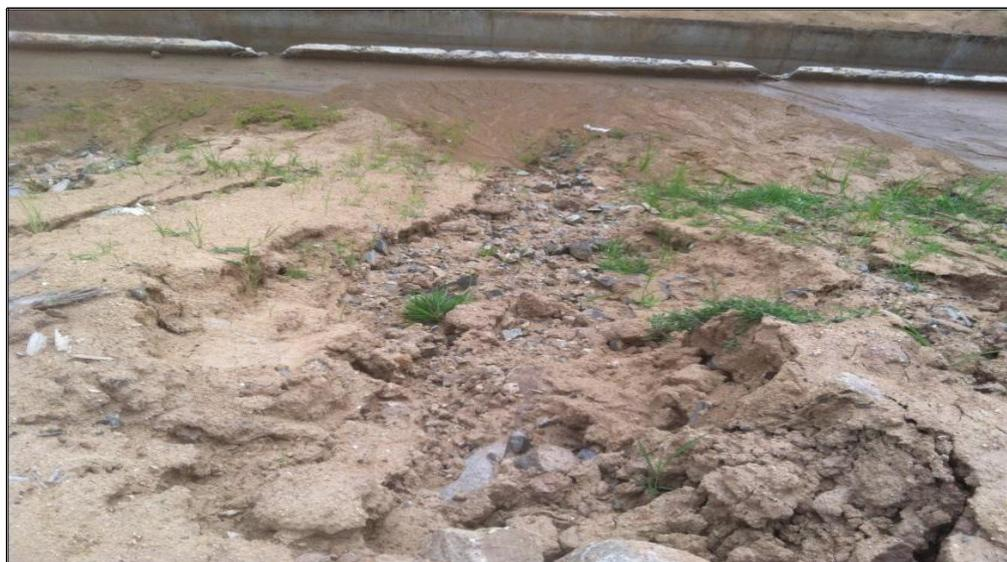
**Foto 7.10.-** Deslizamiento de material erosionado hacia las calles de la urbanización. Fuente: Autores, Agosto 2015.
