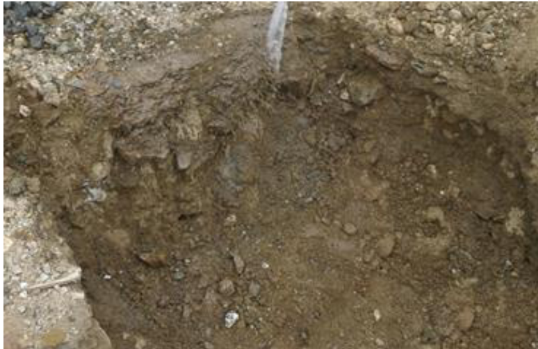
Figura 7: Calicata realizada en terrenos de Espol
