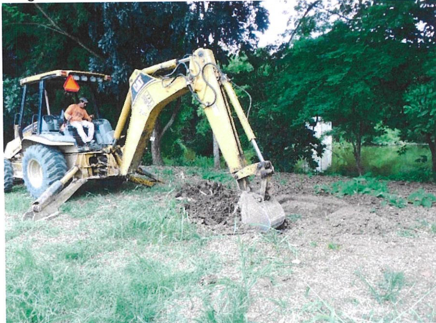
Fotografía 2.2: Retroexcavadora realizando la primera calicata
