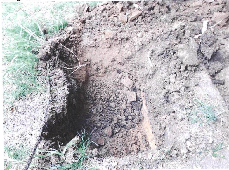
Fotografía 2.3: Calicata 1 realizada en el sitio de estudio
