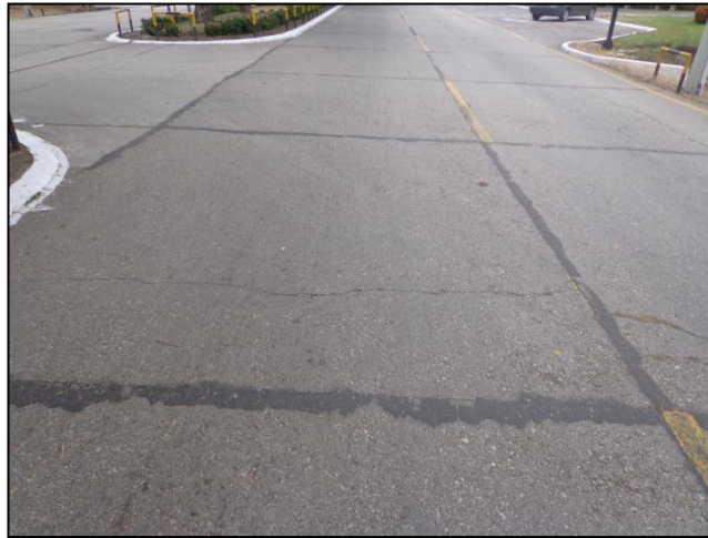
Figura 5-7: Grieta transversal
