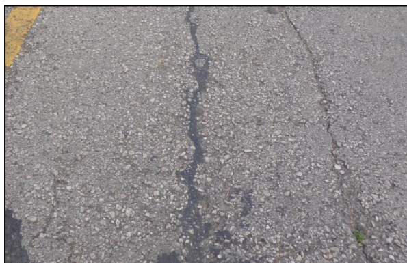
Figura 4-2: Sellado de grietas
