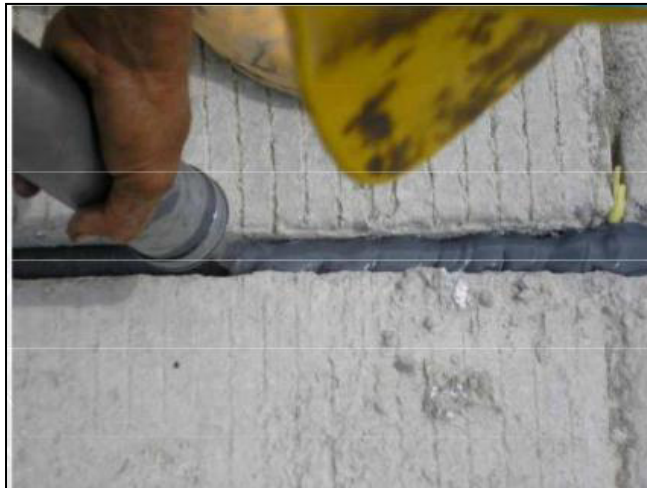
Figura 4-1: Sellado de juntas
