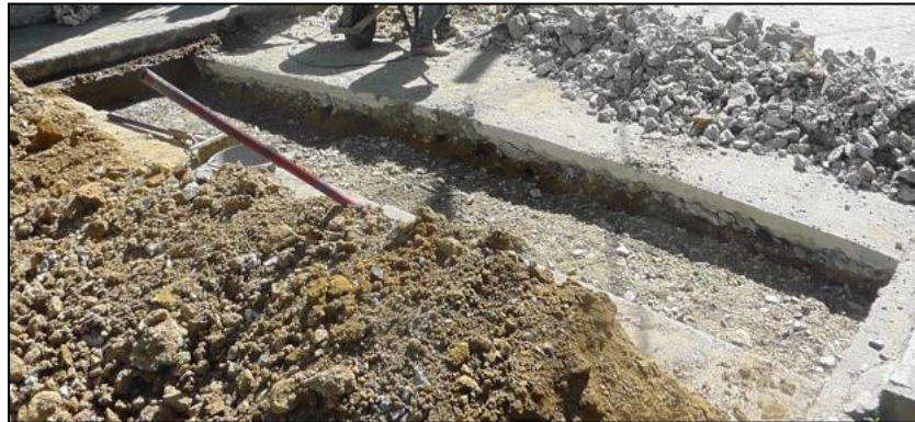
Figura 4-5: Demolición total de profundidad de losa (Fuente: Diario La Patria, Manizales- Colombia)
