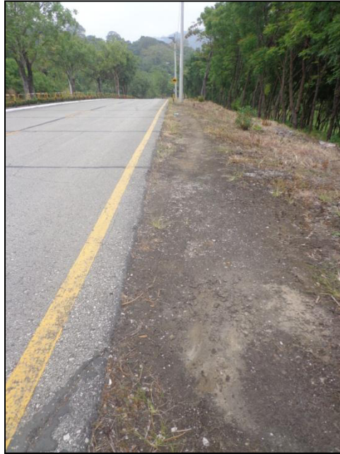
Figura 5-15: Estado de los espaldones
