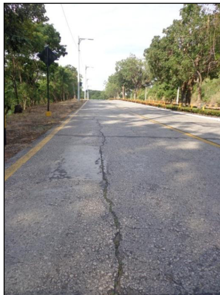
Figura 5-6: Grieta longitudinal
