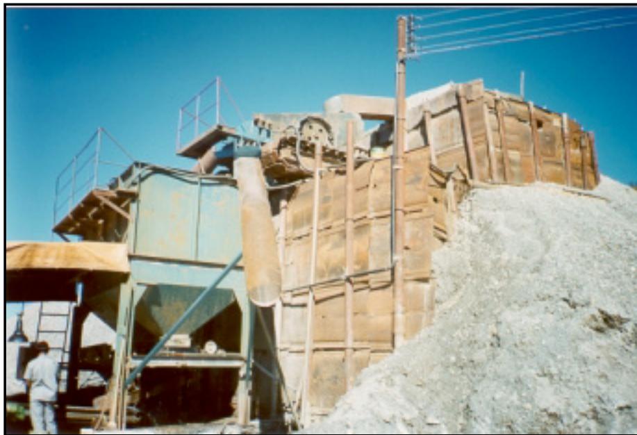
FOTOGRAFIA A6 CONCENTRACION (MALLA ¾" Y MALLA 3/16")
