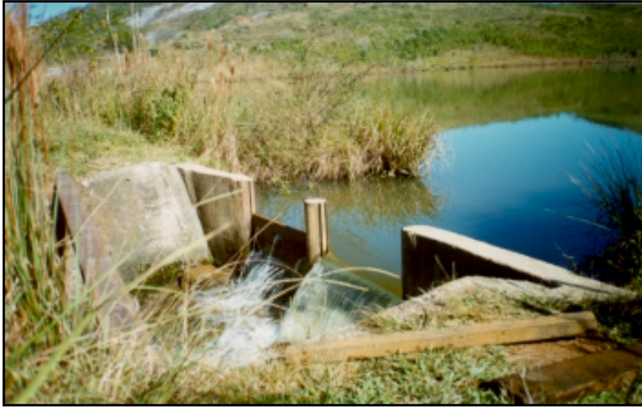
FOTOGRAFIA A1 RESERVORIO DE CAPTACION "CAPAO"
