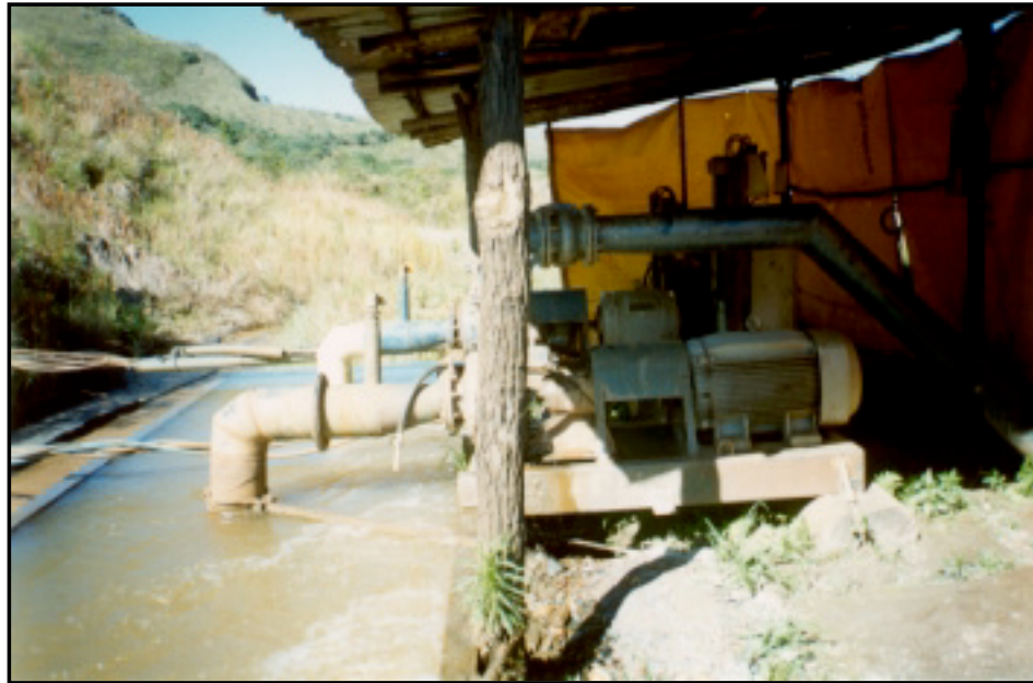
FOTOGRAFIA A3 ESTACION DE BOMBEO DE LA MINA "CAPAO"
