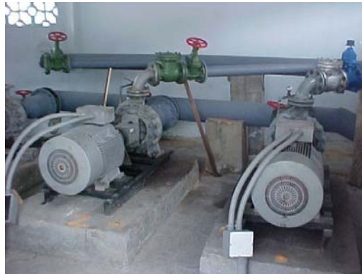
Foto 2 ESTACION DE REBOMBEO
