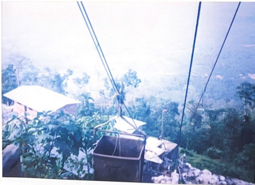
Foto 5.- Bajada del material por el winche
