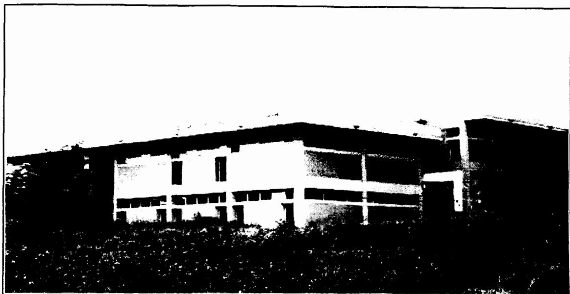
Edificio de Biblioteca y Almacén de Tecnología.
