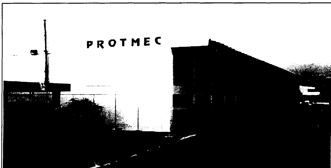
Edificio de PROTMEC.
