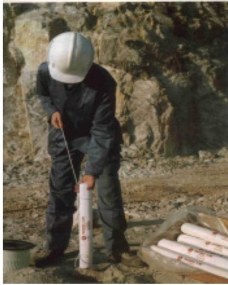
**Figura 1. 8 Riomex E 20 en mediano calibre. (Cortesía de UEE, S.A.)**
