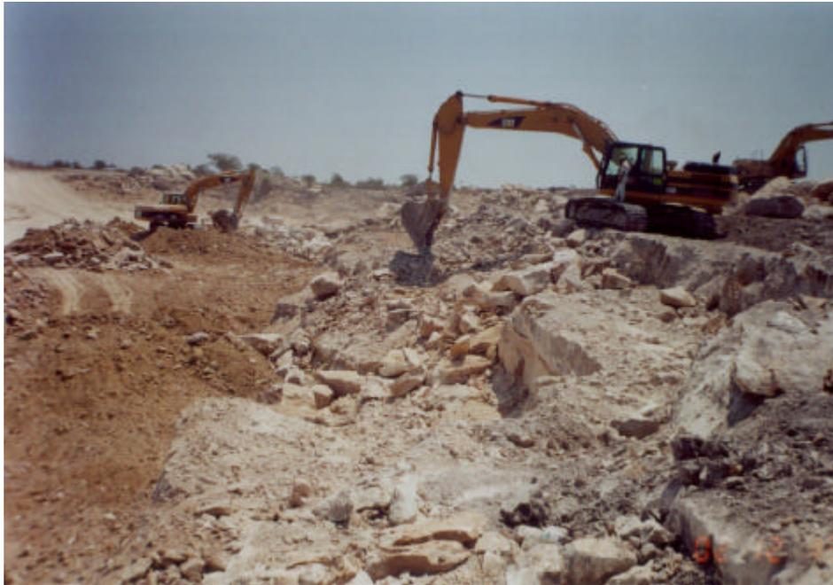
Foto 5: Cantera para producción de los enrocados
