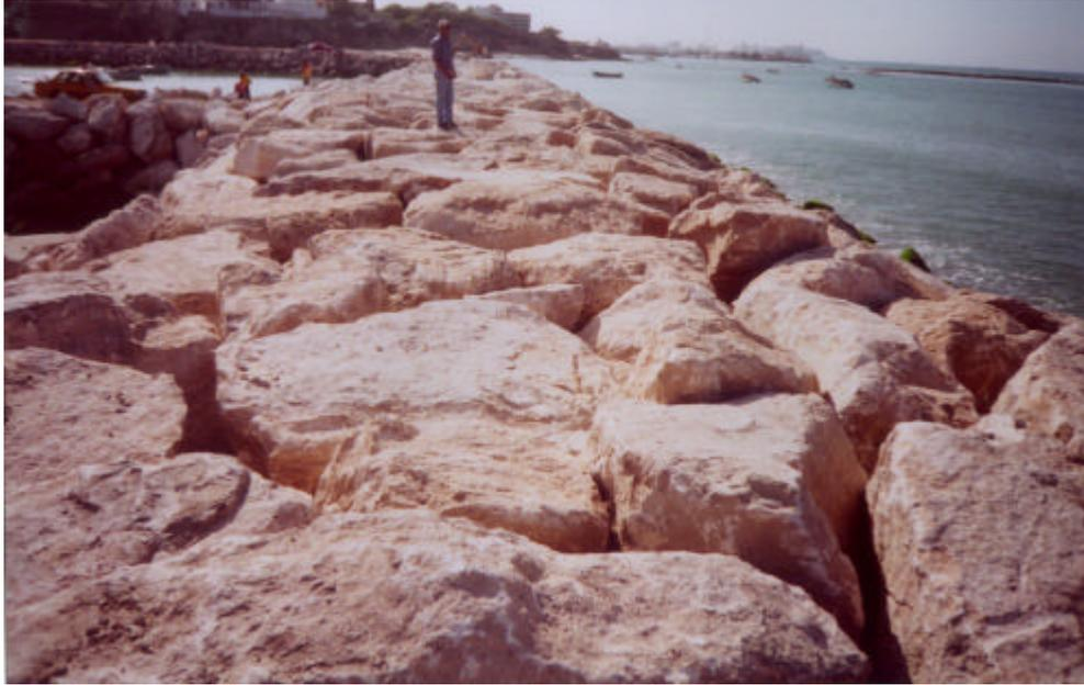
Foto 11: Corona de las escolleras recubierta con enrocado
