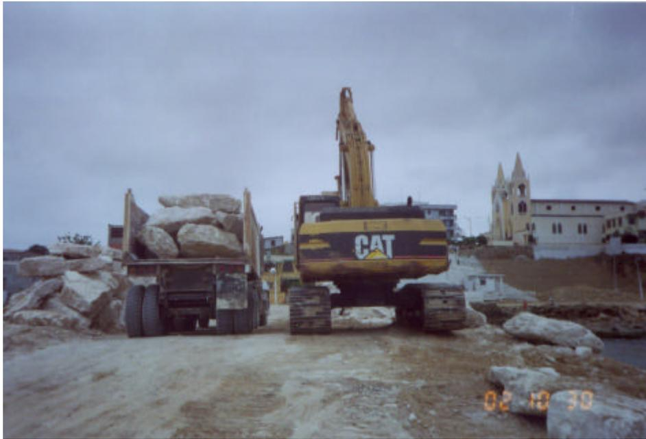
Foto 7: Ancho de accesos permitió el paso simultáneo de volqueta y retroexcavadoras
