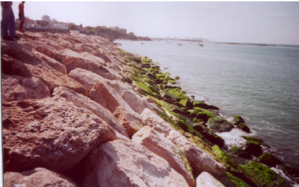
Foto 10: Talud exterior de las escolleras terminado
