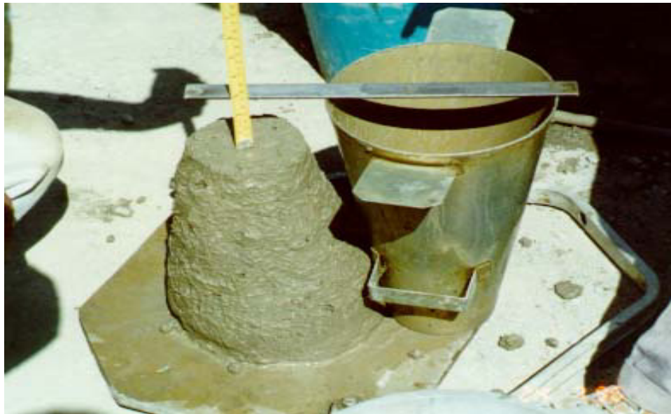
Foto 5.1.1 "Prueba de Revenimiento, en el Cono de Abrams"
