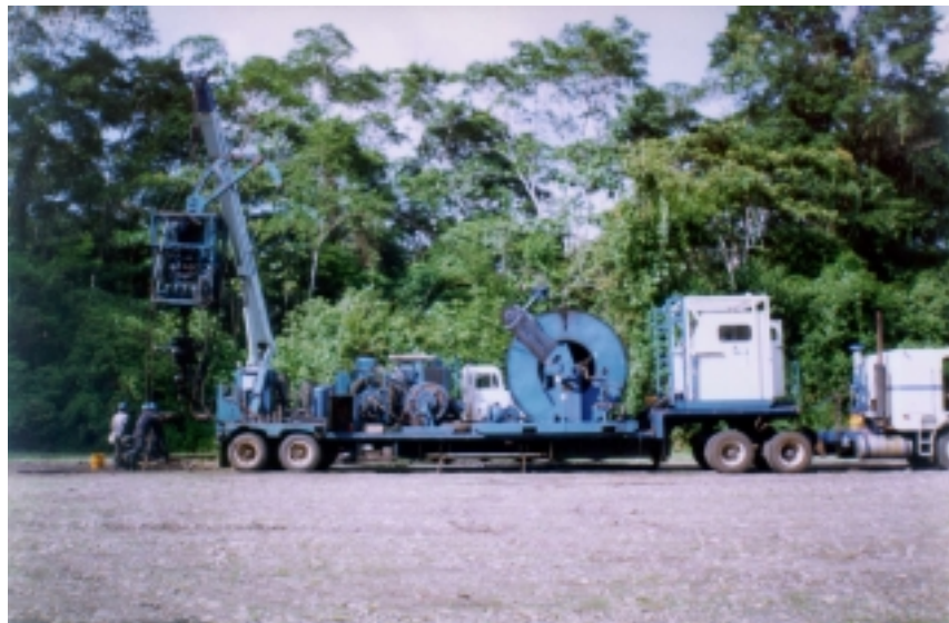
Foto 2.1 Limpieza de incrustación con “coiled tubing” en el pozo SSFD-22 a
