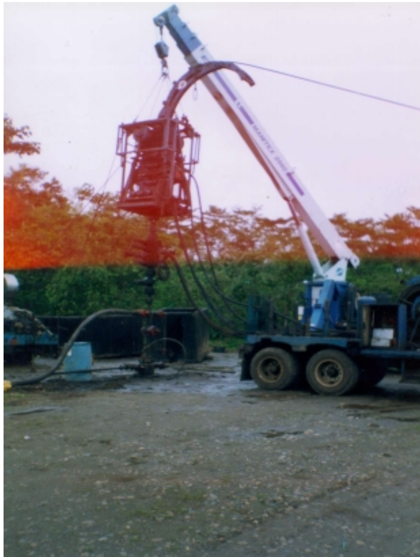
Foto 2.2 Se muestra la cabeza inyectora del coiled tubing y el cabezal del pozo SSF-22A.
