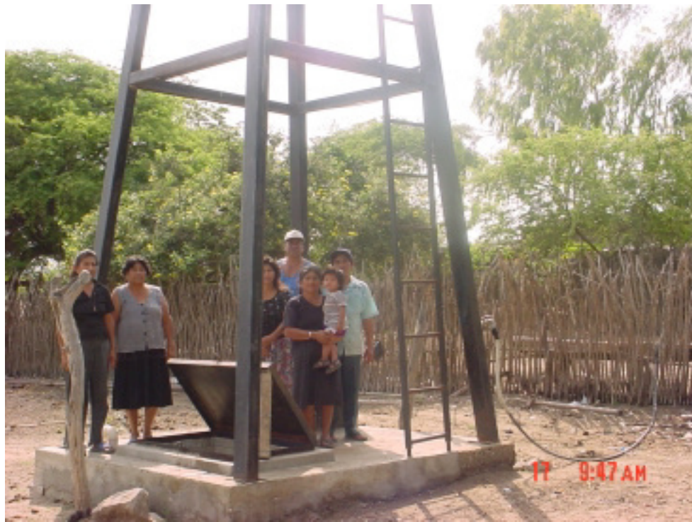
Foto 6. Abastecimiento de agua con pozo de una comunidad en Pechiche.
