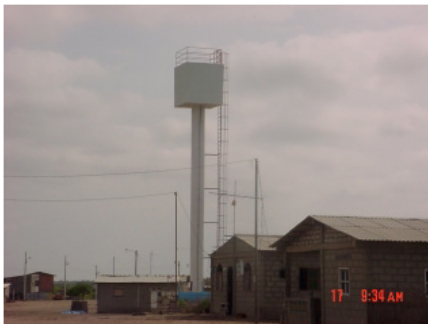
Foto 11. Tanque elevado para almacenamiento de la Junta de Agua Potable de Simón Bolívar.
