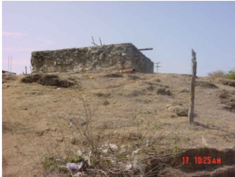
Foto 10. Reservorio de agua ubicado muy cercano al río, para abastecimiento personal.
