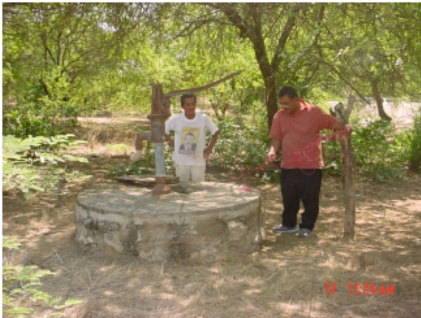
Foto 8. Pozo con bomba manual ubicado en Atahualpa.
