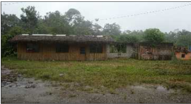
Figura 11. Infraestructura actual en la Comuna Chigüilpe, destinada para la Empresa Tsáchila Chigüilpe.
