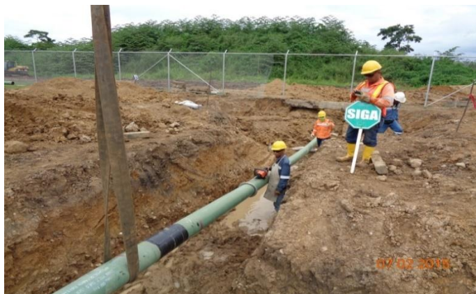
Figura 1.1 Tubería de Poliducto en Proceso de Bajado.
