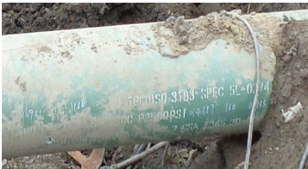
Figura 1.5. Tubería de Diámetro 10.75 in y Espesor 0.279 in. Con el Valor de Presión de Prueba Hidrostática en Fabrica Indicada Sobre la Misma. 2500 psi.
