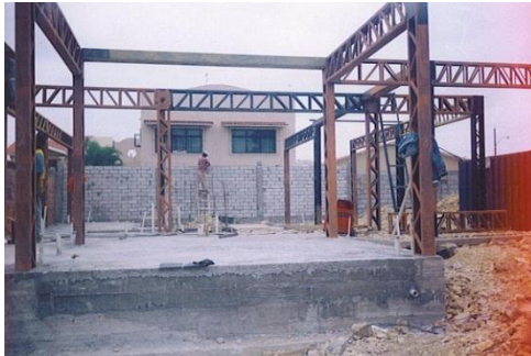
FIG 1.5 ESTRUCTURA METÁLICA PLANTA BAJA
