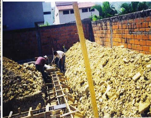
FIG 1.2 ENCOFRADO Y LECHOS PARA CIMENTACIÓN
