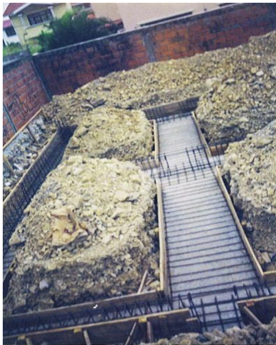
FIG 1.2 ENCOFRADO Y LECHOS PARA CIMENTACIÓN
