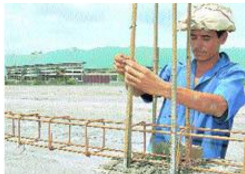
FIG. 1.1 VIGAS ARMADAS DE VARILLAS DE HIERRO
