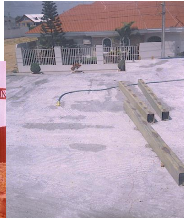
FIG 1.6 FRAGUADO DE LA LOSA
